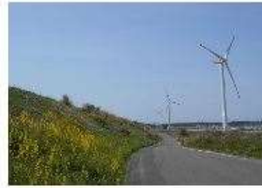
砂丘にある風力発電機
