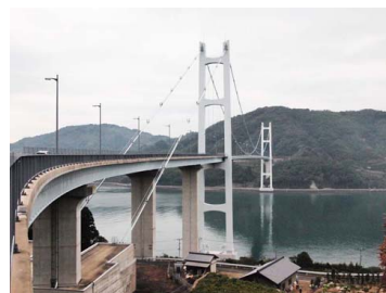
豊島大橋（豊島側から）
