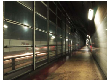
休山トンネルの歩道
