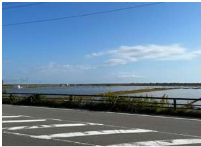
太陽光パネル
