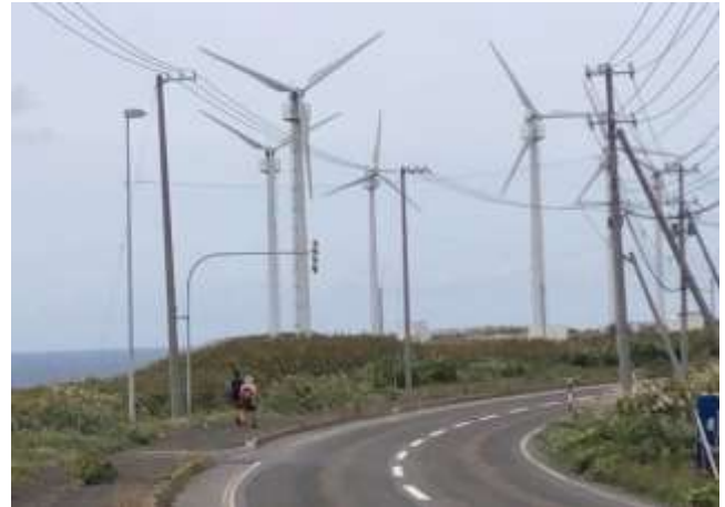
風力発電機群を進む
