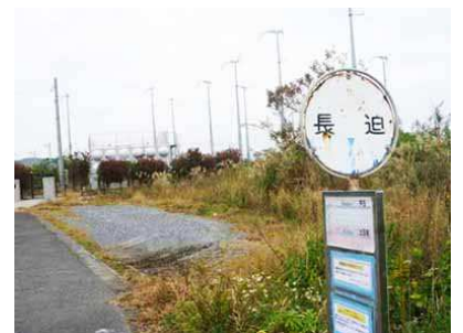
長迫バス停/水道給水施設
