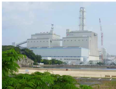
松浦火力発電所のヤードに石炭が山積み（○印）
