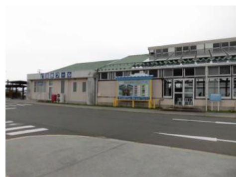
阿武町道の駅温泉プール
