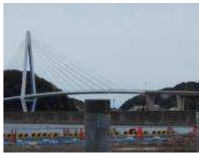
斜張橋の浜田マリン大橋
