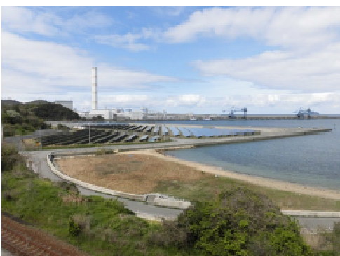
中国電力火力発電所とソーラ
