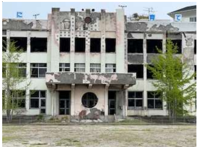
津波と津波火災の状況を残している本校舎 (泰一記)
