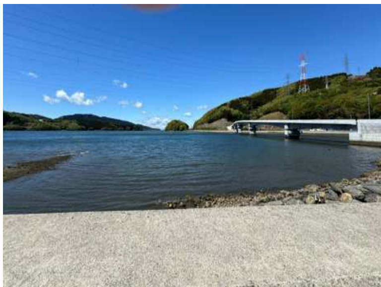
防潮堤より眺め。浦を渡る自動車用の橋
