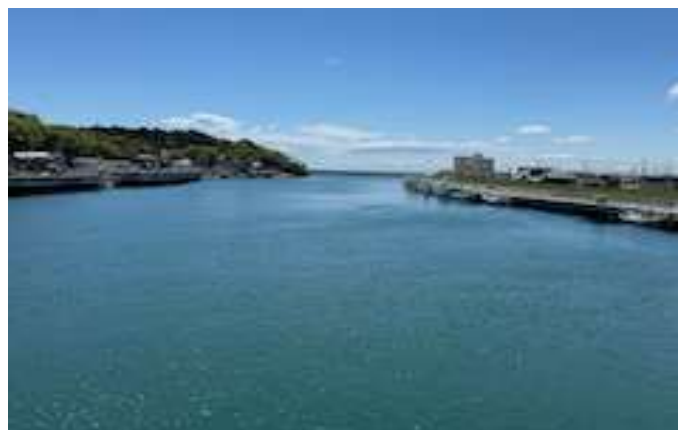
万石橋の上から渡波漁港(左側)
