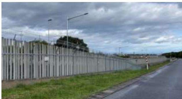
厳重な柵と監視カメラでがっちり守られた施設
