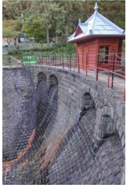
アーチ式ダム全景
