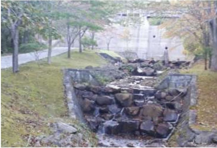
水源池大橋を見上げる
