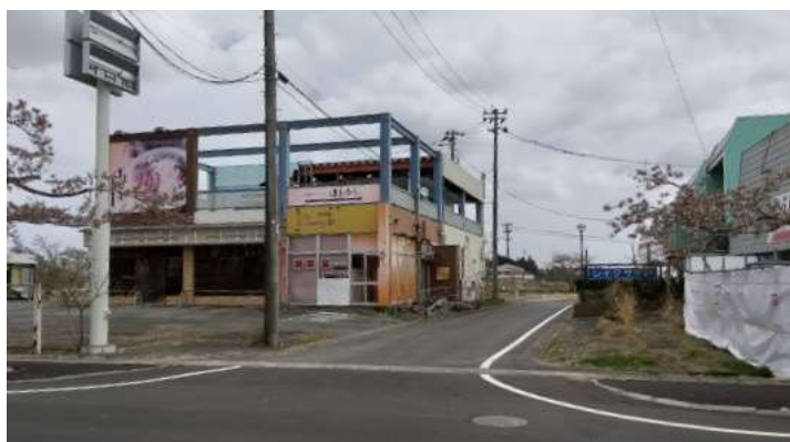
夜ノ森駅前の解体されていない建物(太田撮影)
