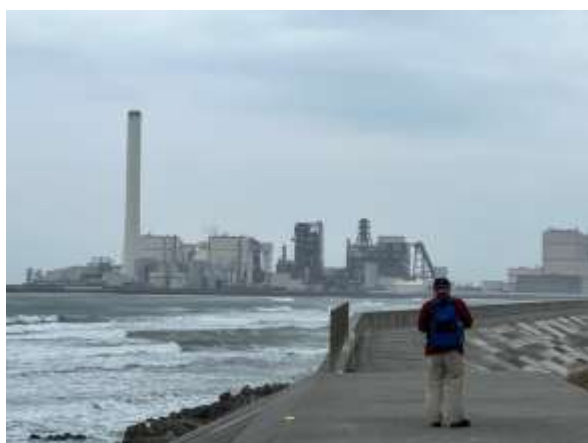
広野火力も災害にあったが、今は IGCC 発電所を設置
