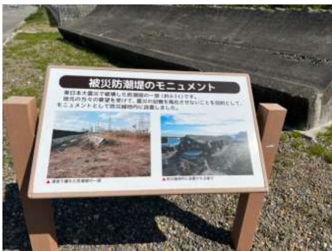
公園の一角に被災防潮堤が展示されている
