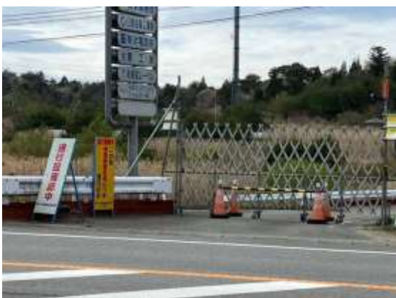
向かいの道路は帰還困難区域のためバリケードで封鎖されている。
