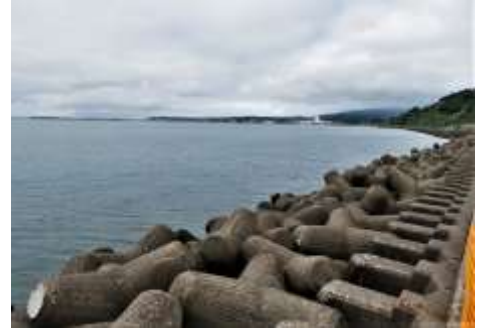
生鼻崎トンネルを抜けた地点
